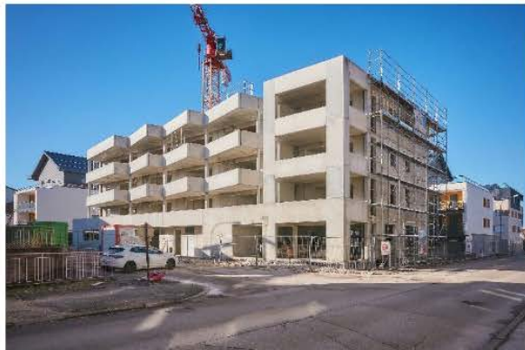
Lot H5 en construction – Goursoll'Immo
