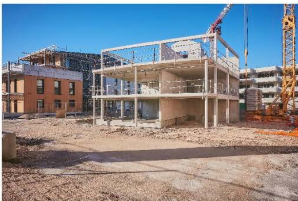
Lot H6 en construction - Néolia
